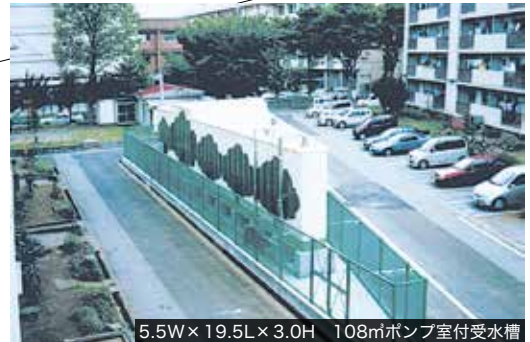
5.5W × 19.5L × 3.0H 108m 3 ポンプ室付受水槽
