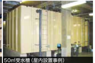
50m受水槽 (屋内設置事例)
