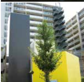
9.4mデザインタンク+ポンプ室
