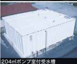
204mポンプ室付受水槽
