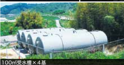
100m受水槽 × 4基
