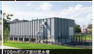
108mポンプ室付受水槽
