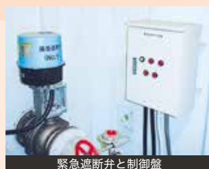
緊急遮断弁と制御盤
